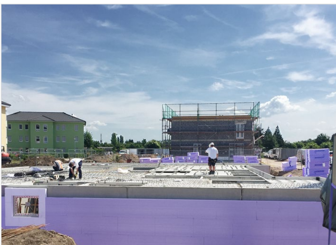
Perimeterisolatie met JACKODUR®
