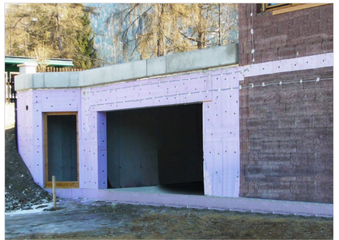
Koudebrugisolatie met JACKODUR® Gefiniert
