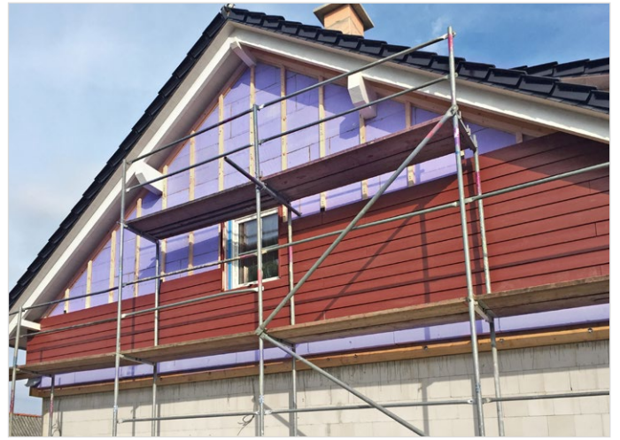
Isolatie achter bekleding met JACKODUR®
