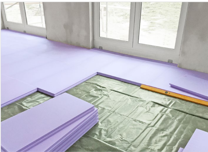
Isolatie onder dekvloer en industriële vloer met JACKODUR®
